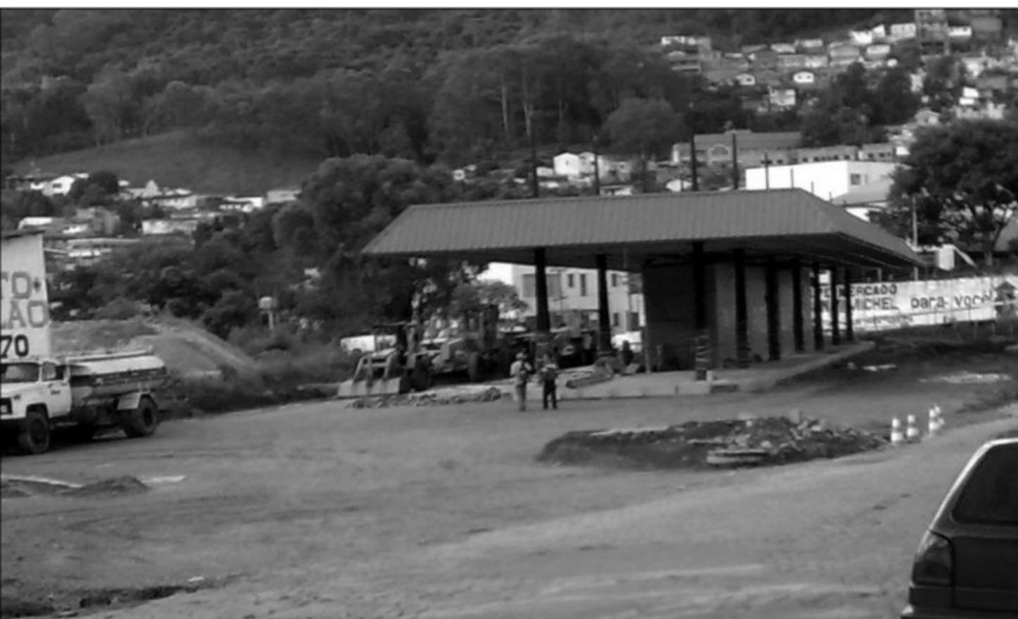
As chuvas estão atrasando ainda mais as obras do terminal da Zona Leste
