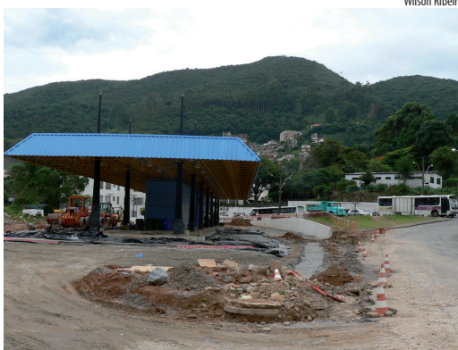
Terminal da Zona Leste: obras estão atrasadas
