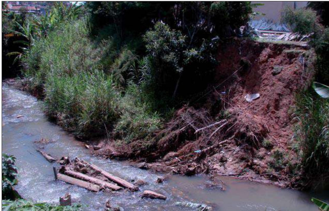
Deslizamento no ribeirão da Serra: a situação está ficando cada vez mais perigosa
