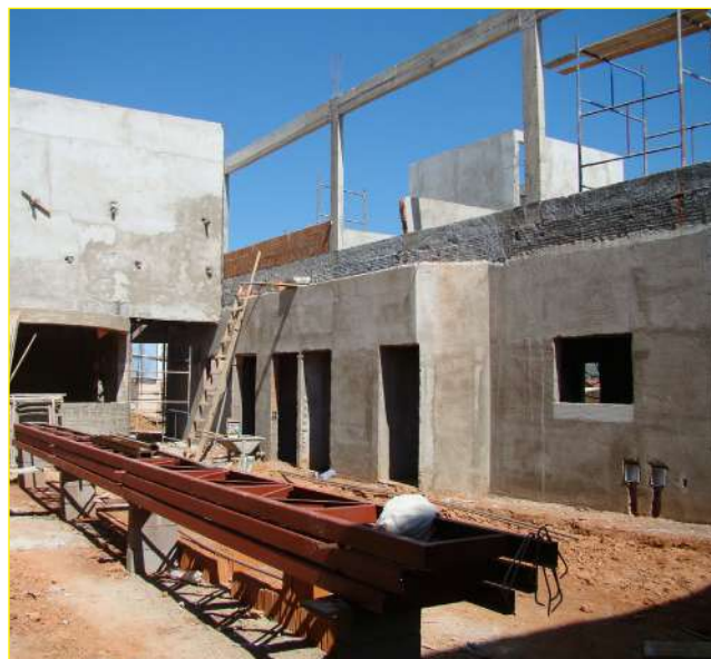
Obras da creche Jd. Kennedy: em breve, mais benefícios para a comunidade
