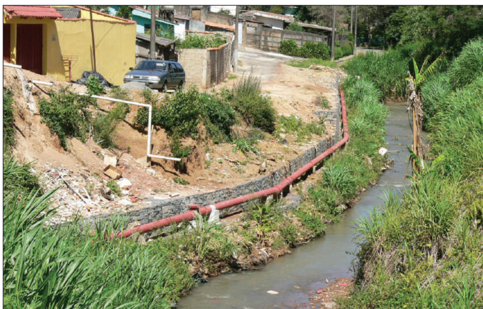
Muro de contenção na Rua Claudina Brandina de Moraes: obra em andamento
