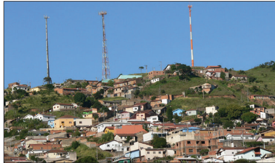
Jd. Colinas: Situação precária se prolonga por décadas e prejudica moradores
