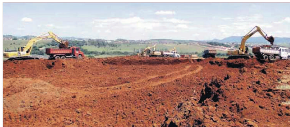
Canteiro de obras da chinesa XCMG, que além de investir R$ 334 milhões na cidade deve formar um cinturão com seis fornecedores na região
