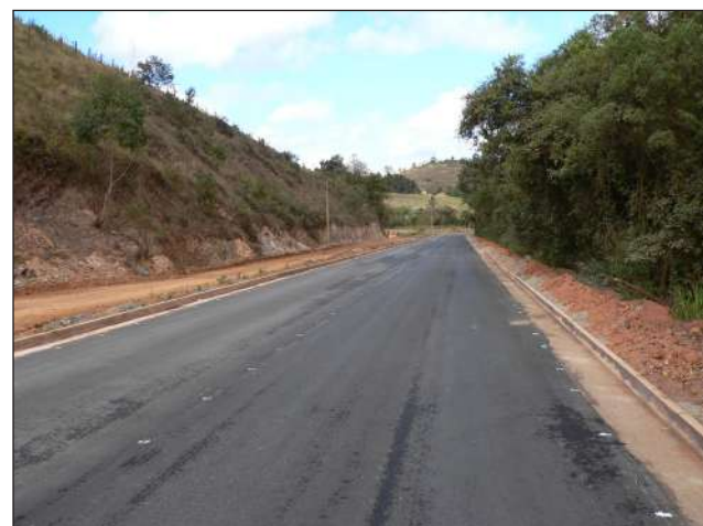
O asfaltamento da estrada da Cachoeirinha já foi concluído
