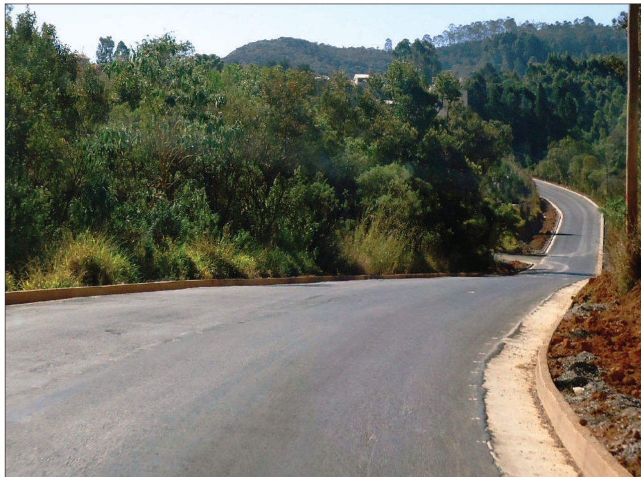
O progresso está chegando: com o asfalto, a região começa um novo ciclo de desenvolvimento e progresso
