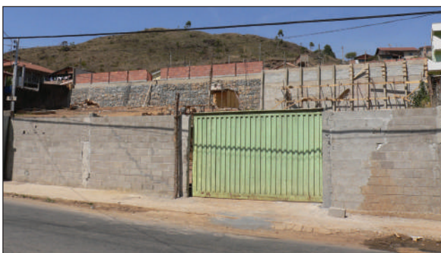
Ritmo acelerado, em busca do tempo perdido: creche em construção no bairro Estância São José
