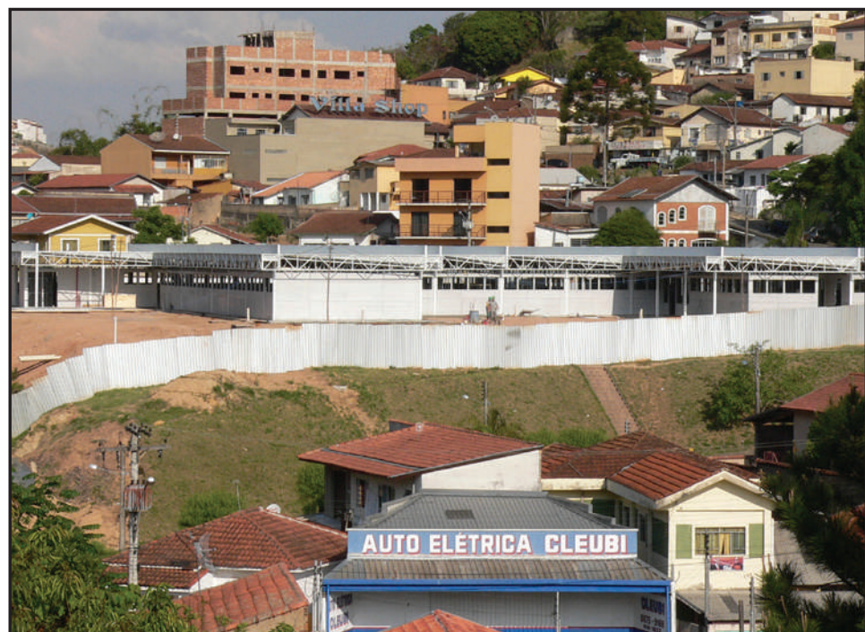
UPA 24 Horas, no bairro José Carlos: obras em ritmo acelerado
