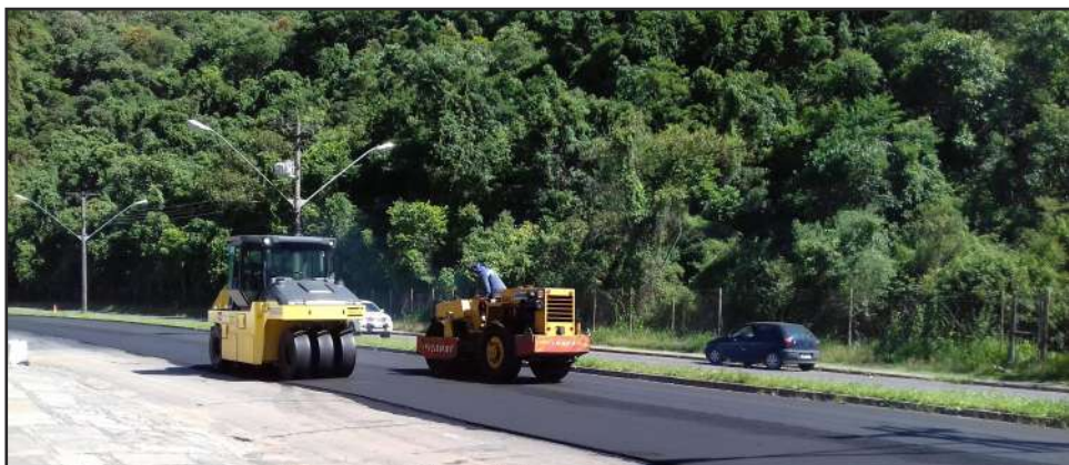
Avenida Wenceslau Braz recebeu o novo asfalto em toda a sua extensão
