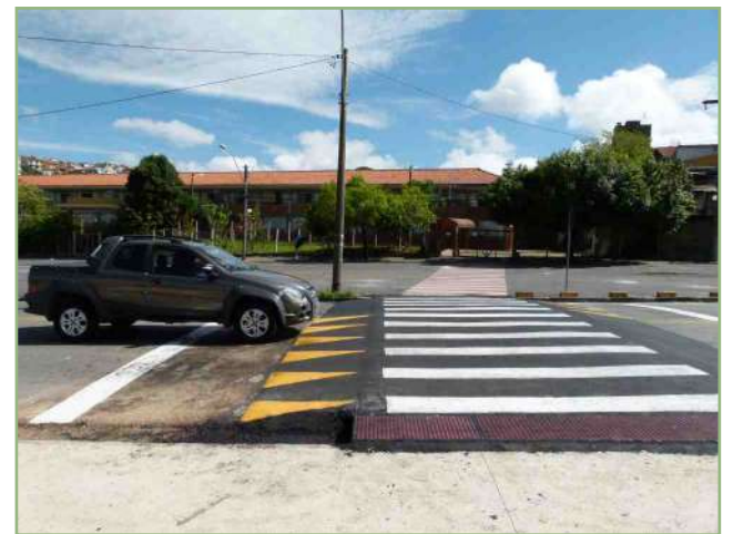
Travessia elevada melhora a segurança na região da Escola Municipal Edir Frayha, no Nova Aurora
