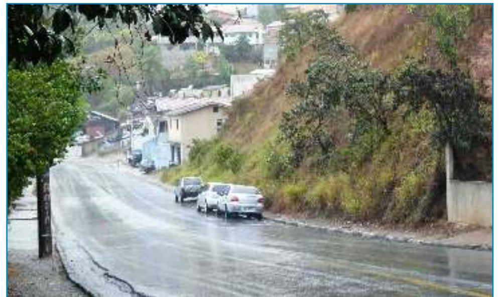
Trechos sem calçadas na Cel. Virgílio Silva obrigam pedestres a caminharem pelo meio da rua
