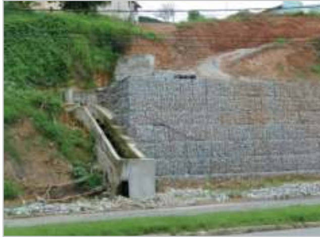
Sistema de drenagem de gabião próximo à Artec não suporta o volume de água e sempre inunda pista sentido bairro - centro
