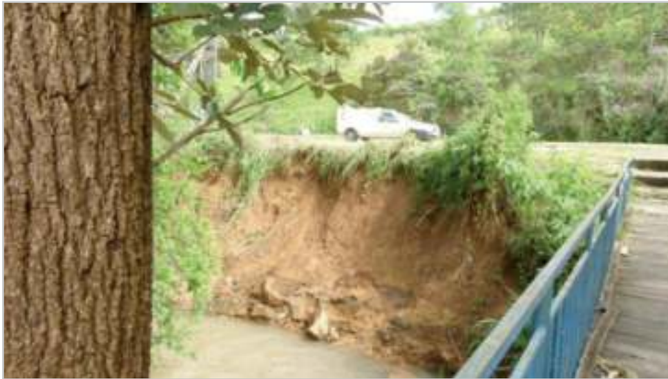
Trecho do ribeirão próximo à pinguela do Dom Bosco está desmoronando e está chegando à pista
