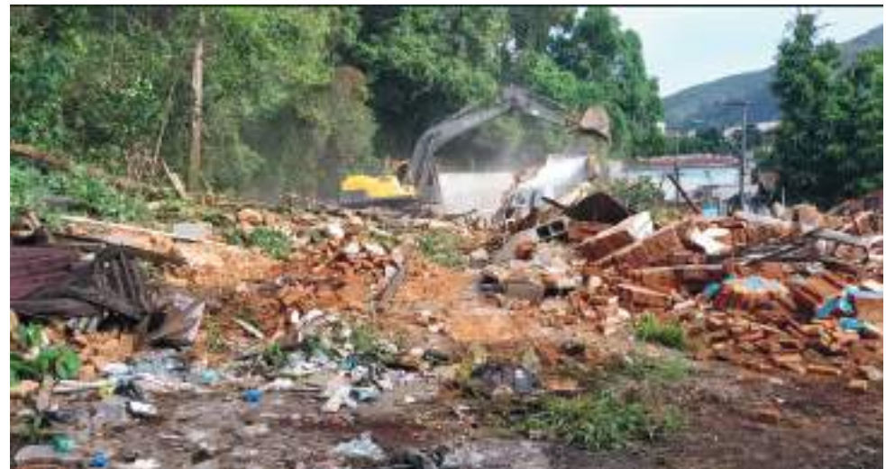
Depois de duas décadas de descaso e abandono, a antiga Creche Maria do Rosário Bastos foi demolida
