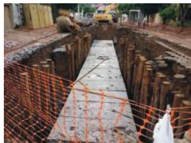
Substituição dos tubulões na Av. Ubirajara M. Moraes
