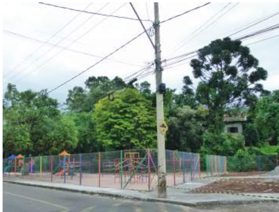
Obras do parquinho infantil do bairro Dom Bosco estão praticamente concluídas
